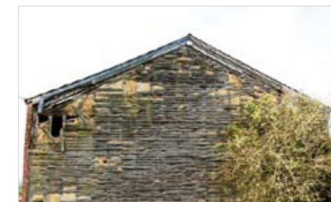
Pignon à Petite-Chapelle
