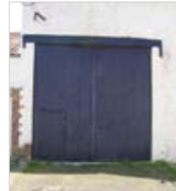
Linteau droit en bois
