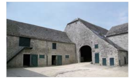
Ferme en quadrilatère à Corenne.
