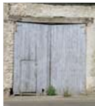
Linteau droit en bois
