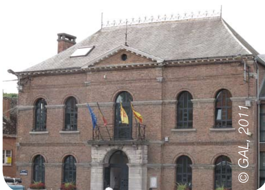
Commune de Florennes Maison Communale
